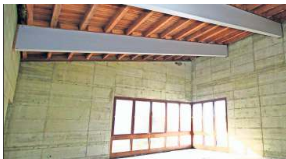
Auch im Sitzungssaal sind jetzt die nackten Mauern und Decken frei gelegt.
