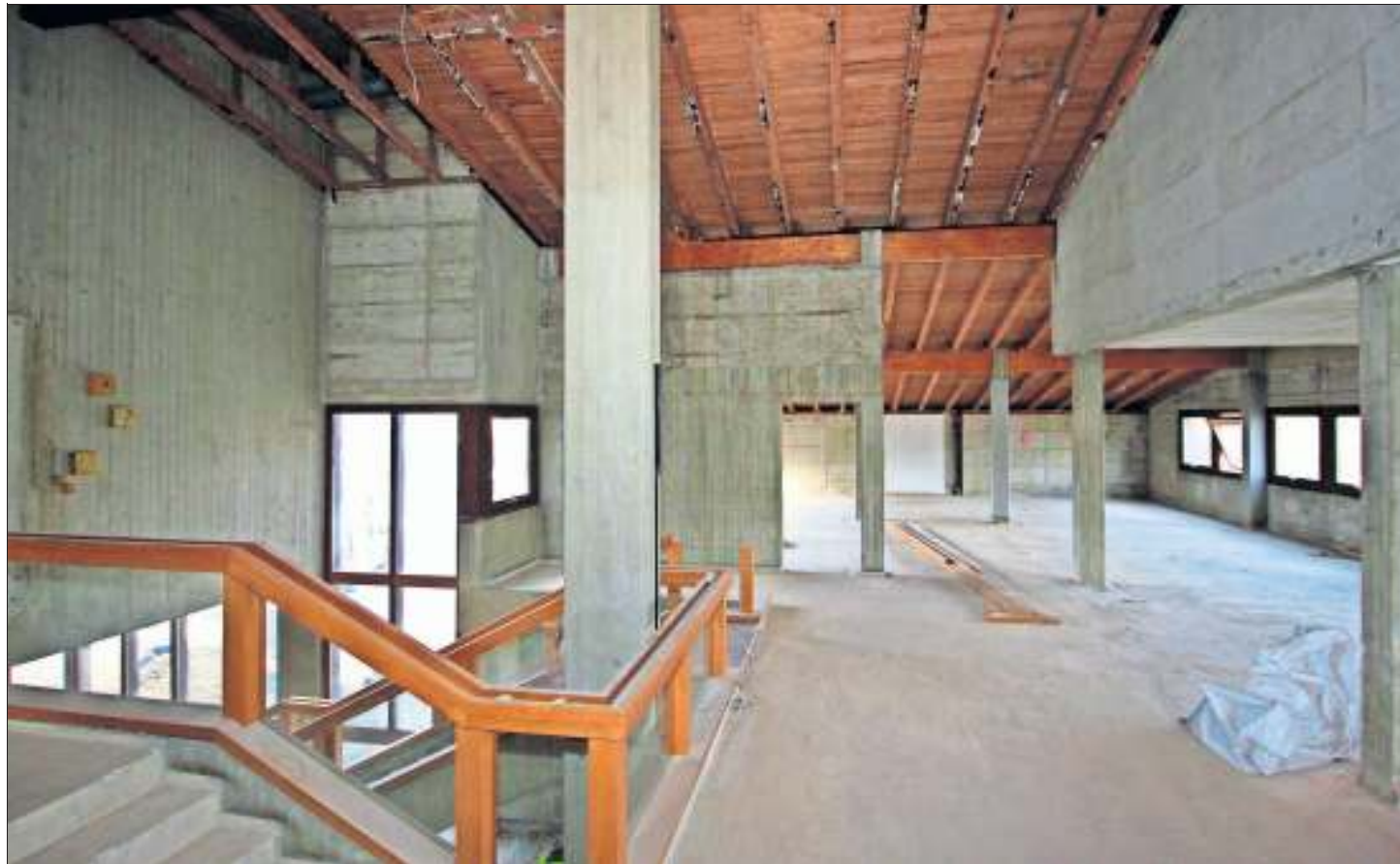
Ungewohnten Durchblick bietet das Pleidelsheimer Rathaus nach dem Abbruch sämtlicher Innenwände.
